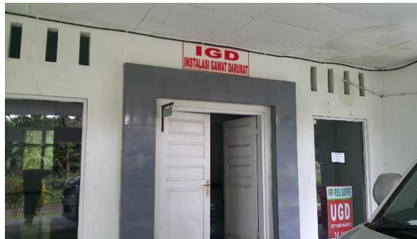
D5. Gedung IGD Lama
