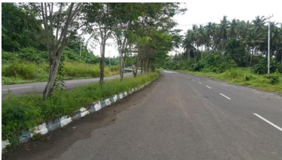
Tampak Jalan Depan RSU Sofifi 1
