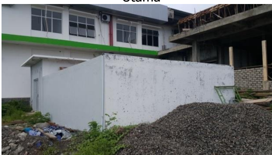
Gambar 5. 9 Tempat Penampungan Air Pelayan Gedung Utama
