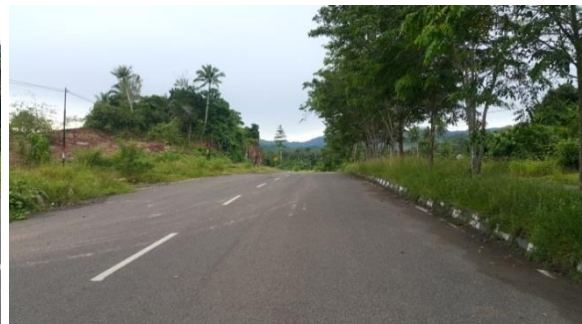
Tampak Jalan Depan RSU Sofifi 2
